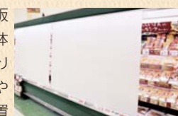
ナイトカバーで冷気漏れを抑制し、電力消費を抑制
