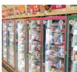
発熱量が少ないLEDは冷ケースでの使用が効果的
